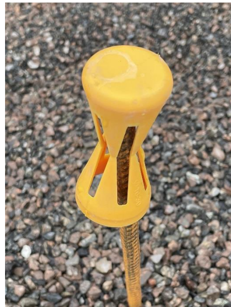
Bilde 7 viser armeringsbeskytter i bruk.
