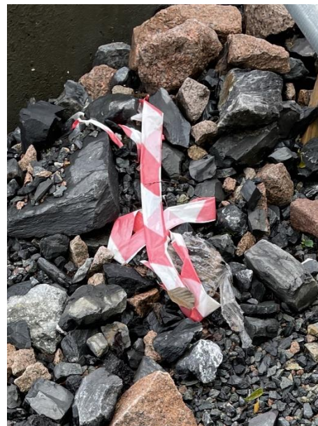
Bilde 11 viser sperrebånd observert inne på prosjektområdet.
