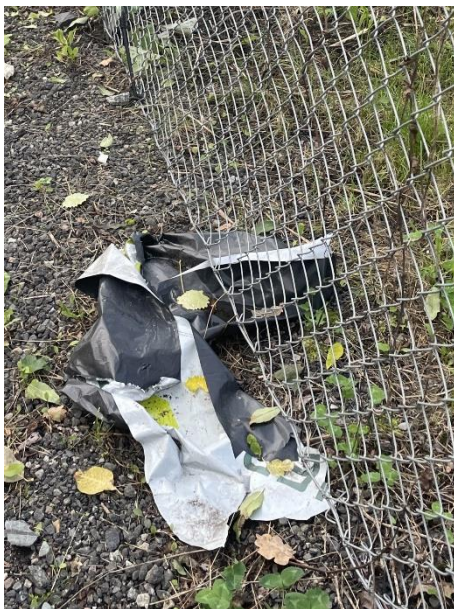
Bilde 10 Viser emballasjeplast fra byggemateriale på vei ut fra prosjektområdet.
