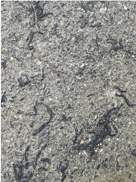
Bilde 19 viser avkapp fra rør, som viste seg å være utfordrende å få bort fra grunnen.
