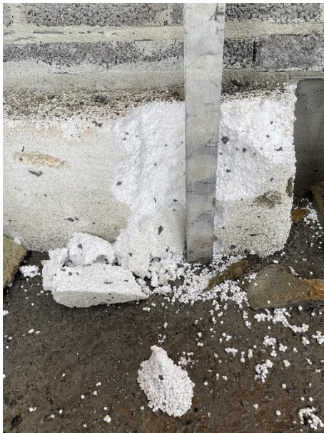
Bilde 22 viser EPS som er kuttet for tilpasning, som resulterte i biter og smuler.
