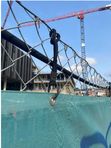
Bilde 24 viser flerbruksfeste i stedet for strips for å henge opp byggegjerdeduk.
