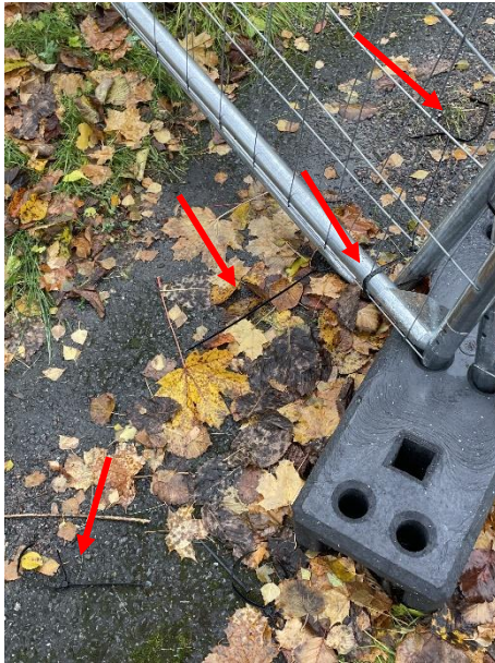
Bilde 4 viser avklippede strips på innsiden og utsiden av byggegjerdet, samt strips som fortsatt er festet i gjerdet.
