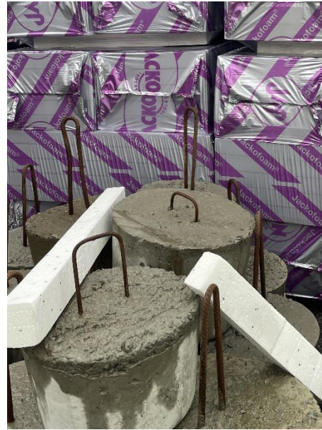
Bilde 3 viser to hvite EPS-støtter benyttet mellom stabling av XPS. Øverst i bildet kan det observeres to EPS-støtter i bruk.
