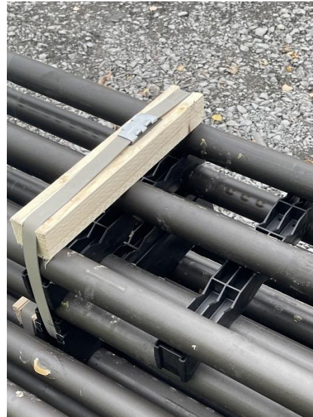
Bilde 6 viser sort støtte for stabil stabling. Flere støtter ble observert på grunnen i område for mellomlagring.
